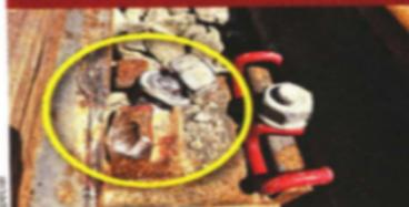
En la imagen se observa la falta de sujetadores en los rieles.
